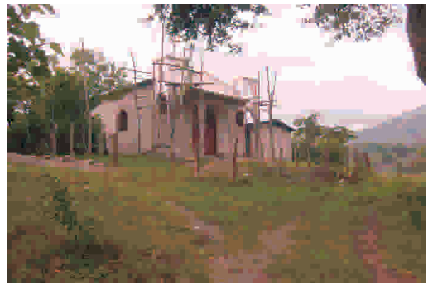
Construcción Iglesia de San José las Brisas. Mayo de 2008.
