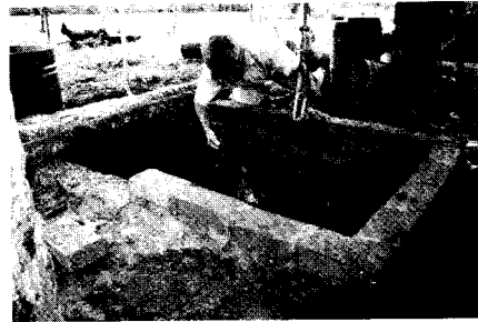
Foto 11: Construcción de brocal en ambos pozos en Finca Normandía. Foto: Archivo FAFG.
