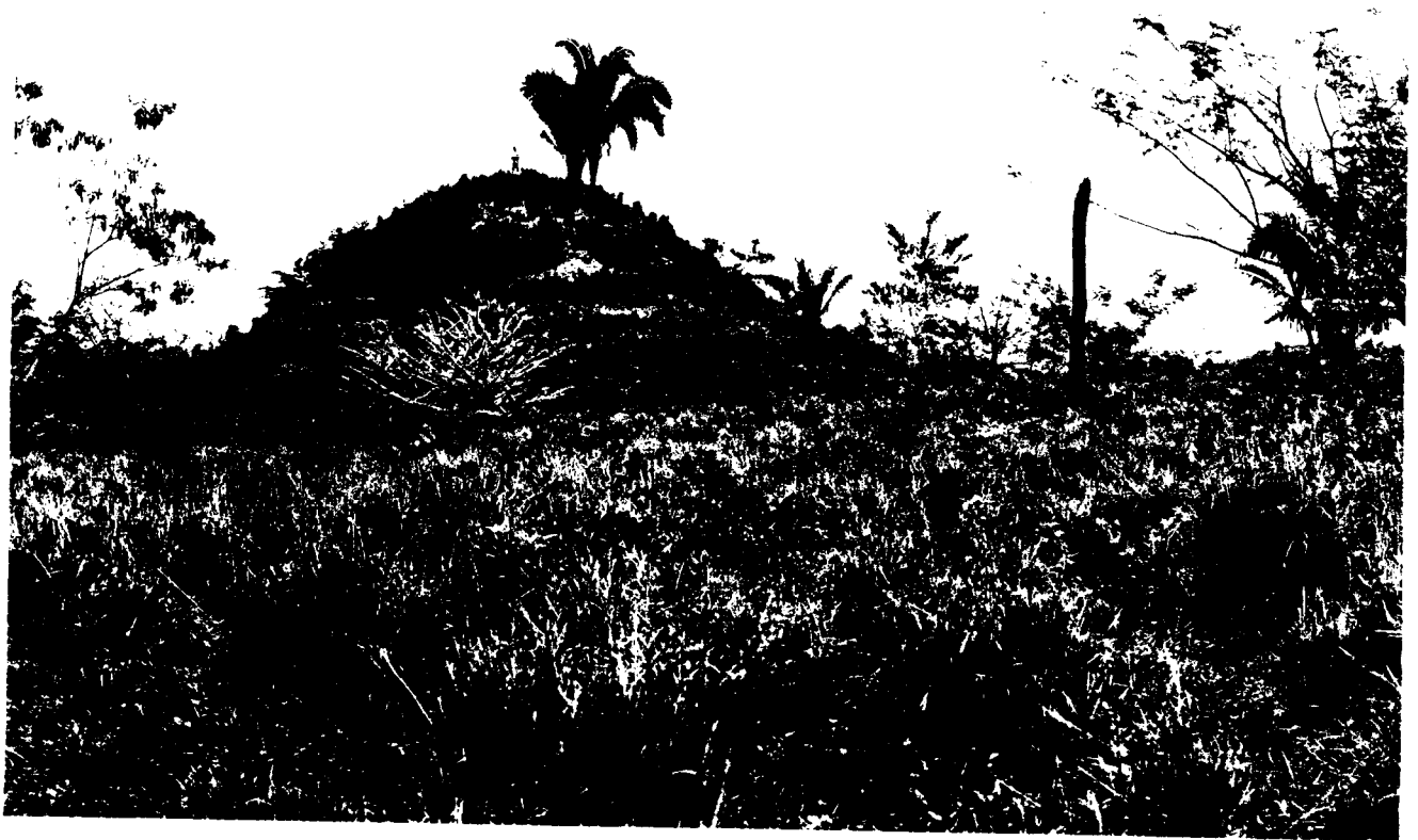
ESTRUCTURA 10, foto tomada por E. Shook en 1969
