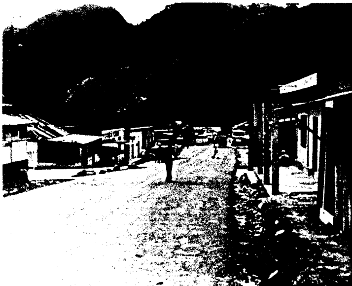
La estación "Belisario Domínguez", en la zona cafetalera de Chiapas, México.
