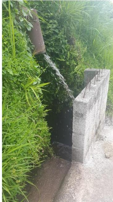
**Figura 11.** Fotografía de tubería de descarga de agua residual de planta empacadora
