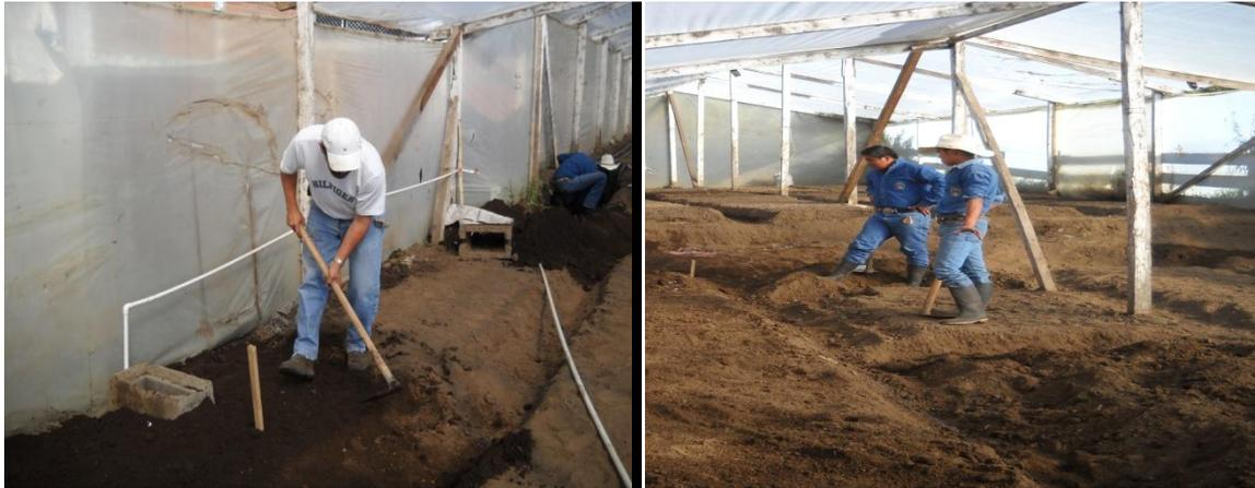
Fotos: zanja donde va la tubería principal
