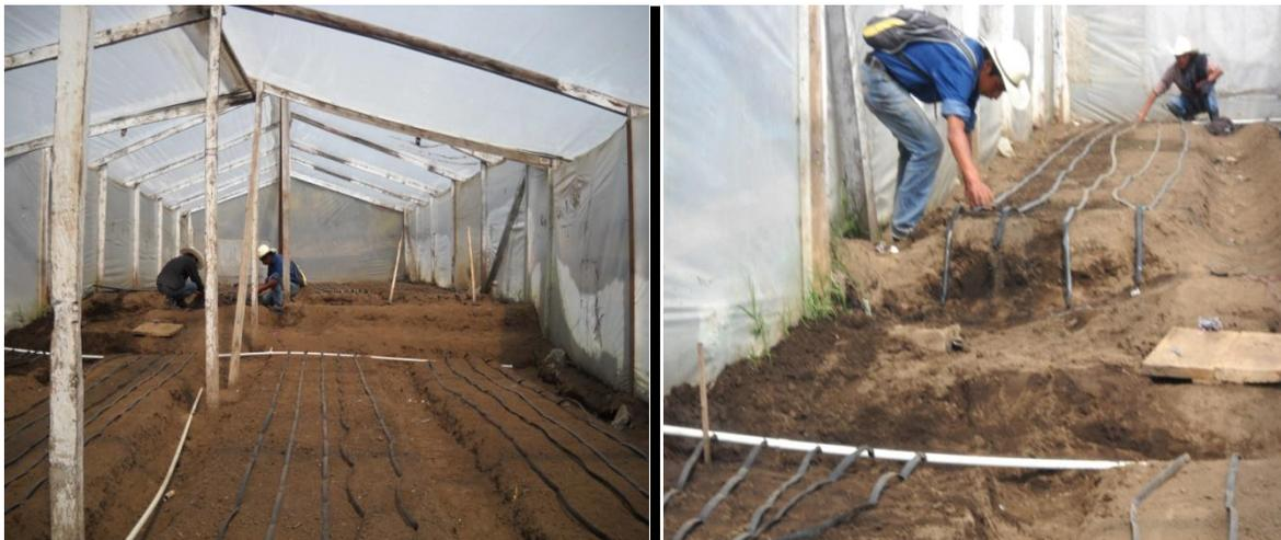
Fotos: de las mangueras laterales del sistema de riego por goteo.
