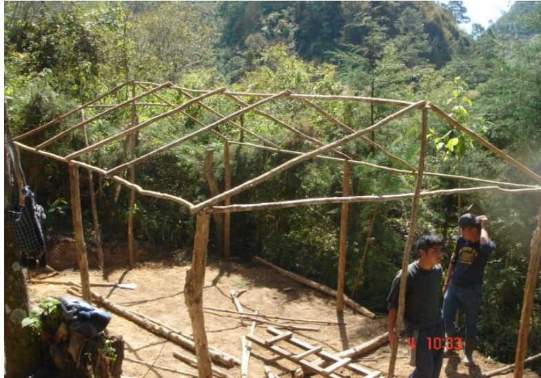
FIGURA 33. Elaboración de terraplén y armado de la estructura FUENTE: Elaboración propia
