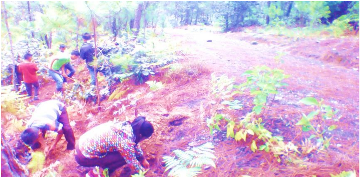
Perforación de hoyos para la plantación de los árboles y 8 plantados ya para la mostración como se plantan.
