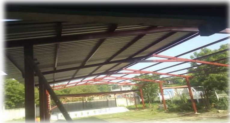
Foto # 11: Colocación de lámina a la estructura metálica del Salón para Usos Múltiples
