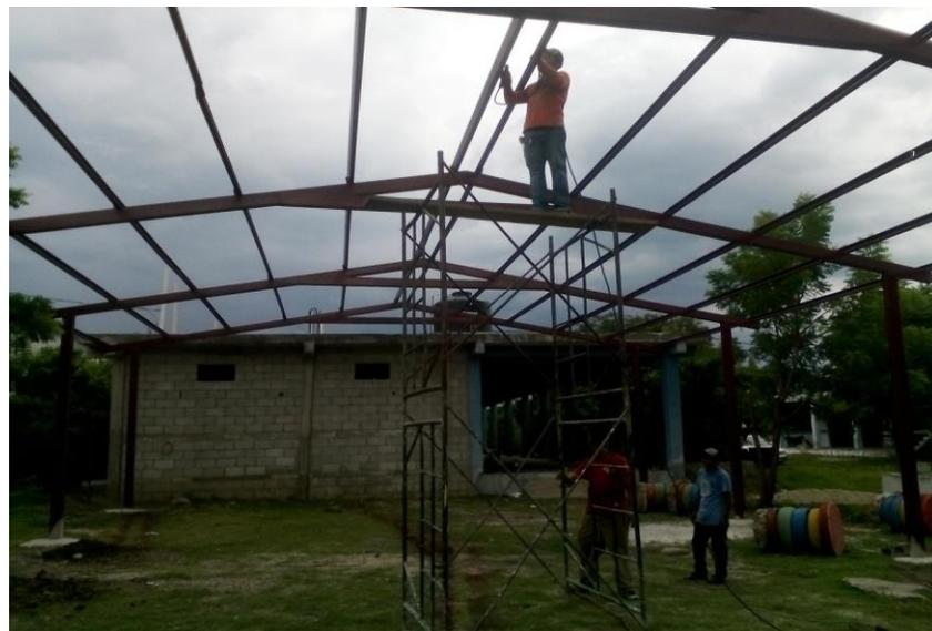
Soldadura de costaneras de metal para base del techo. Formación de vigas y travesaños.
