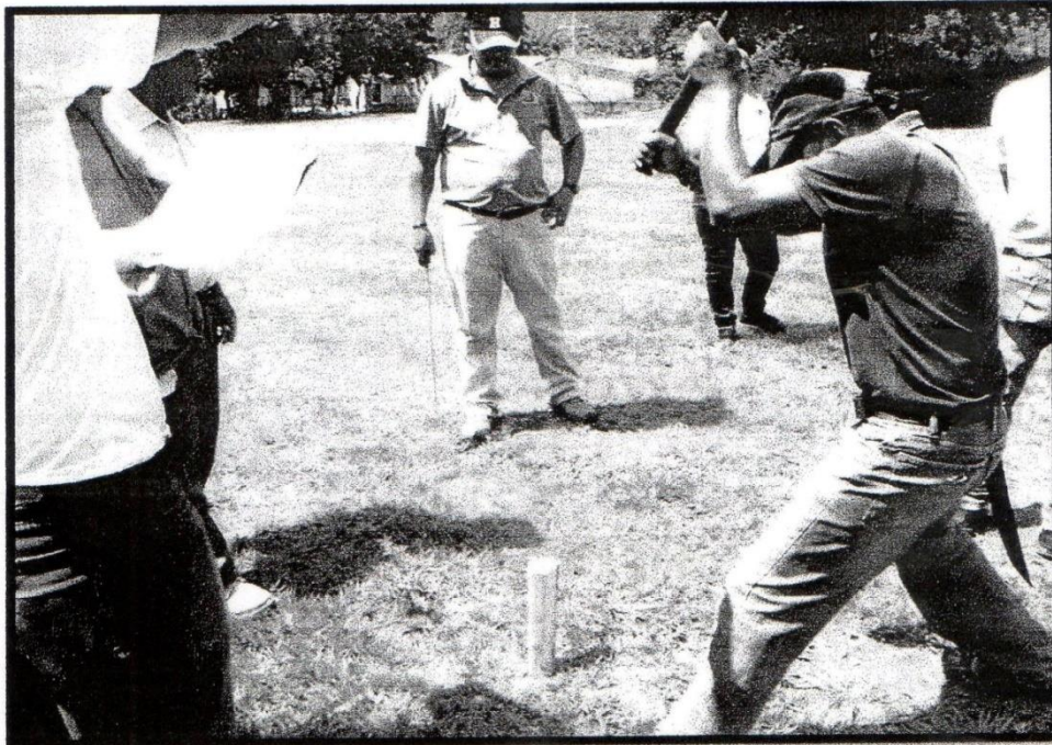
Realizando la Limpieza y estaqueado del terreno.
