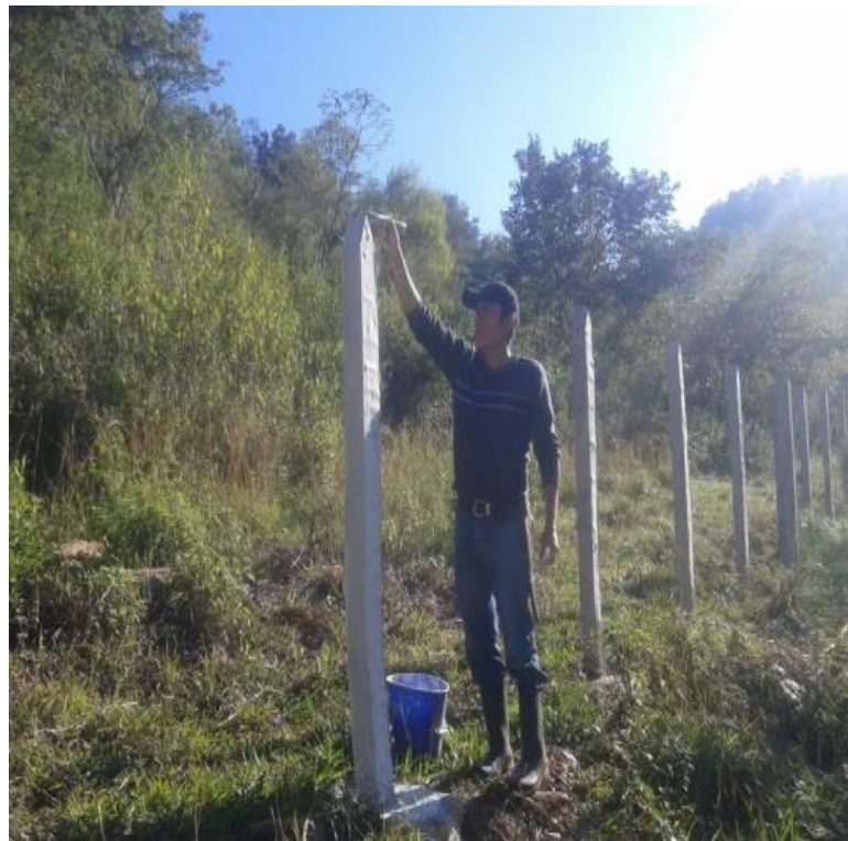
Epesista pintando los postes con cal.
