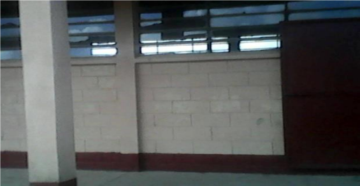
Paredes con pintura
