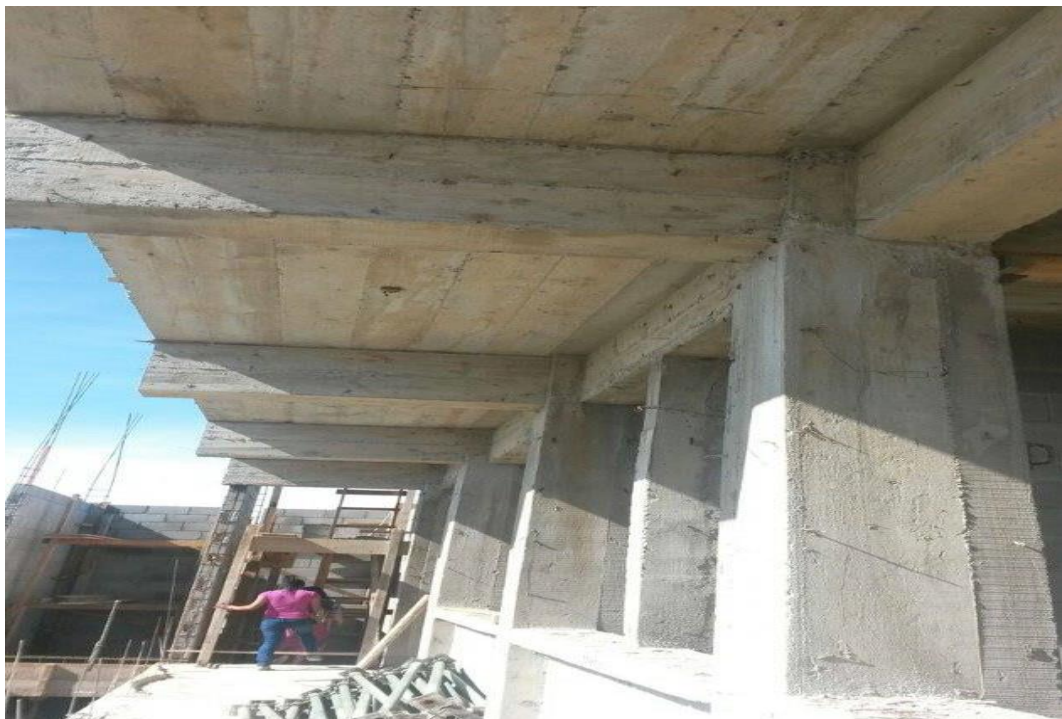
Construcción culminada, dos aulas de la Facultad de Humanidades sección Chimaltenango ya cuenta con techo de losa.
