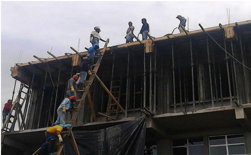
Fundición realiza por albañiles, en la Facultad de Humanidades Chimaltenango.
