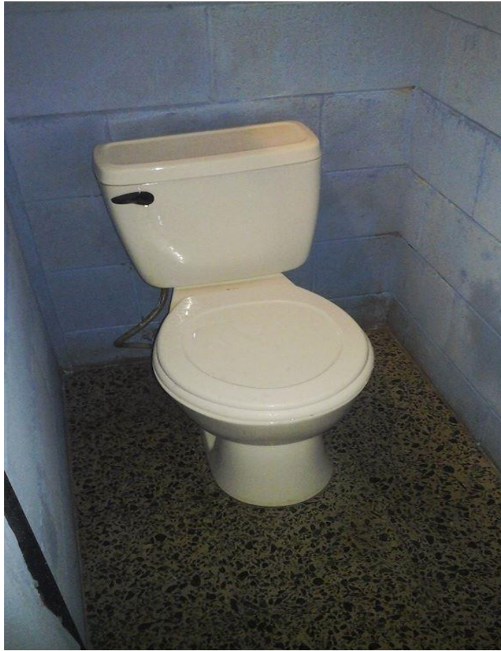
En la imagen se observa los sanitarios ya colocados.
