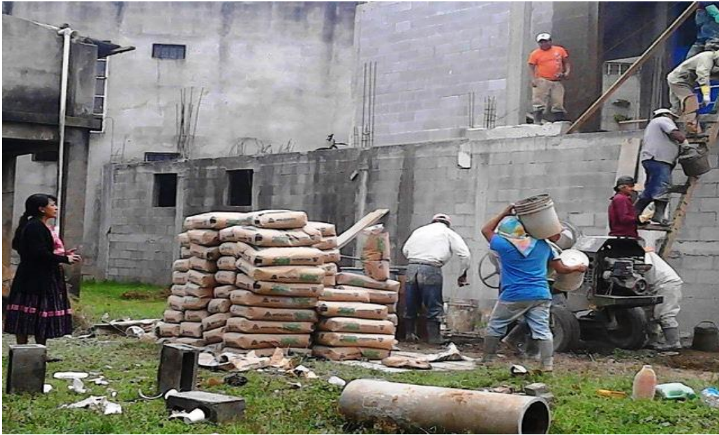
Supervisión de la construcción por parte de la Directiva de Epesista.
