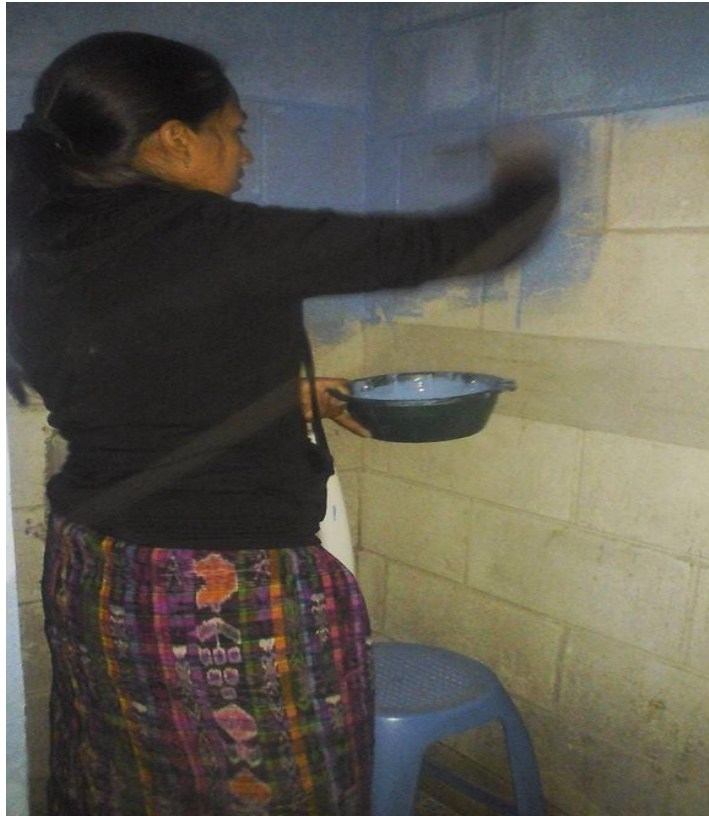
Se está pintando las paredes del área de sanitarios.
