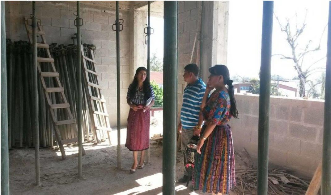
Epesistas evaluando la culminación de fundición del tercer nivel.
