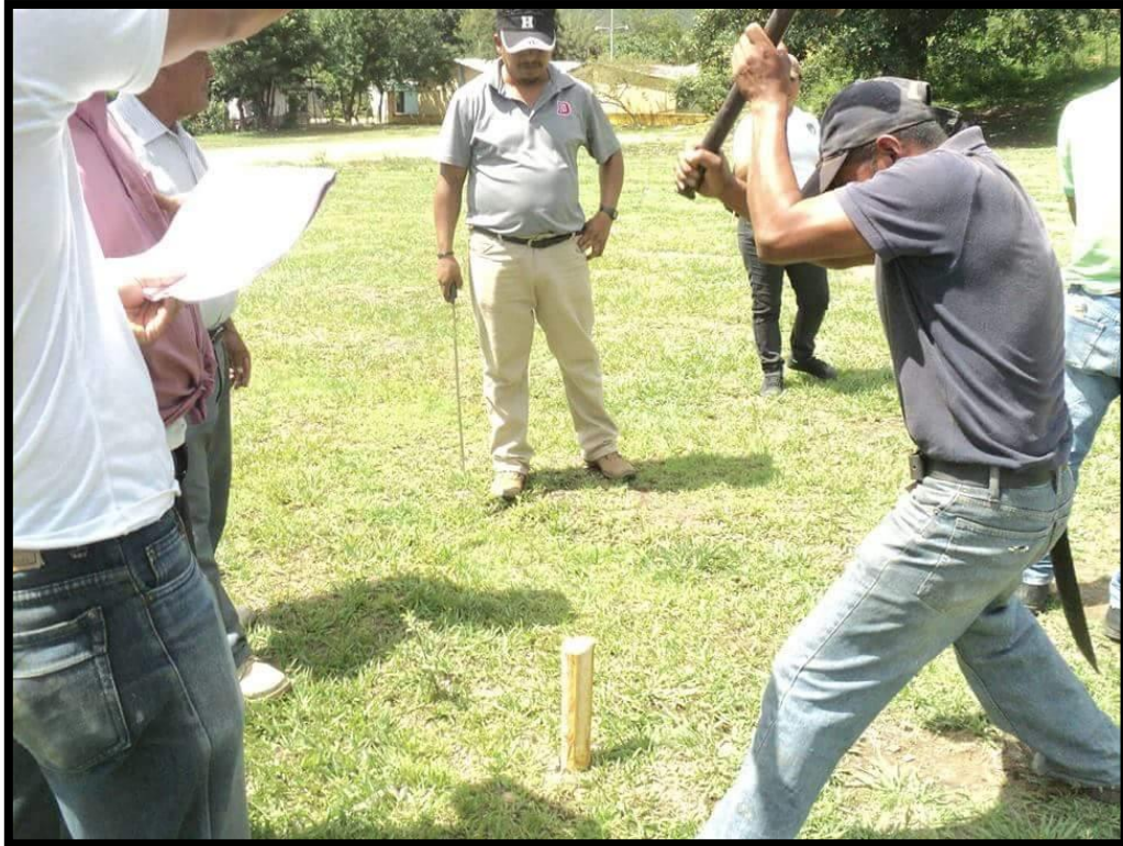
Realizando la Limpieza y estaqueado del terreno.
