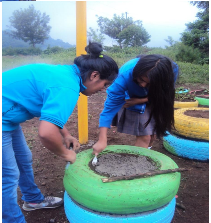
FIGURA 13. Relleno de concreto la parte de arriba de las llantas.
