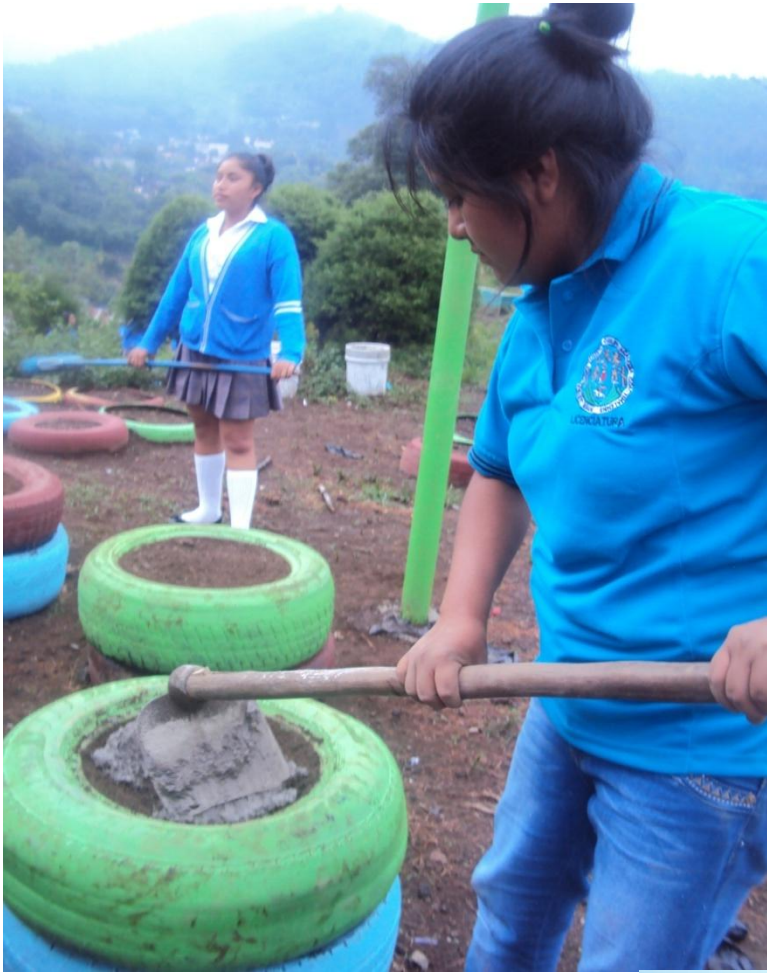
FIGURA 12. Relleno de concreto la parte de arriba de las llantas para poder sentarse mejor.
