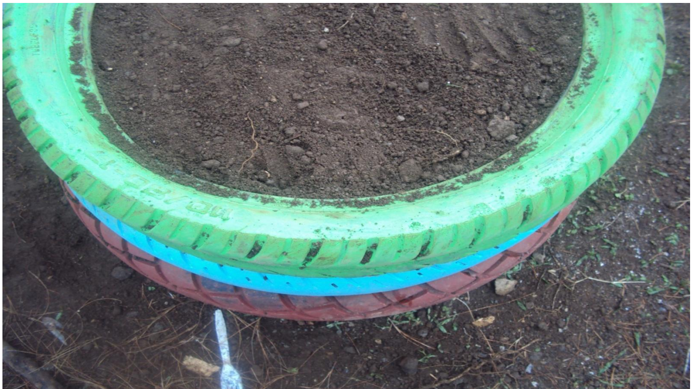
FIGURA 7. Neumáticos llenos de tierra.
