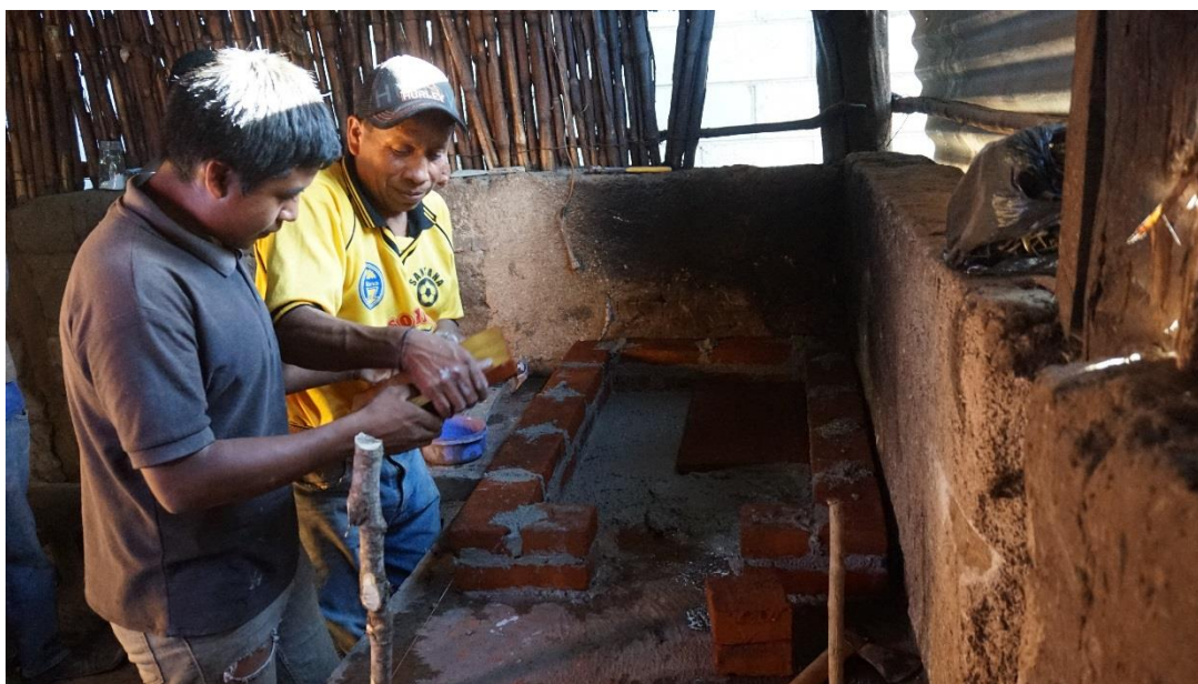
Construyendo la cámara de calor Foto tomada por Mario Hernández
