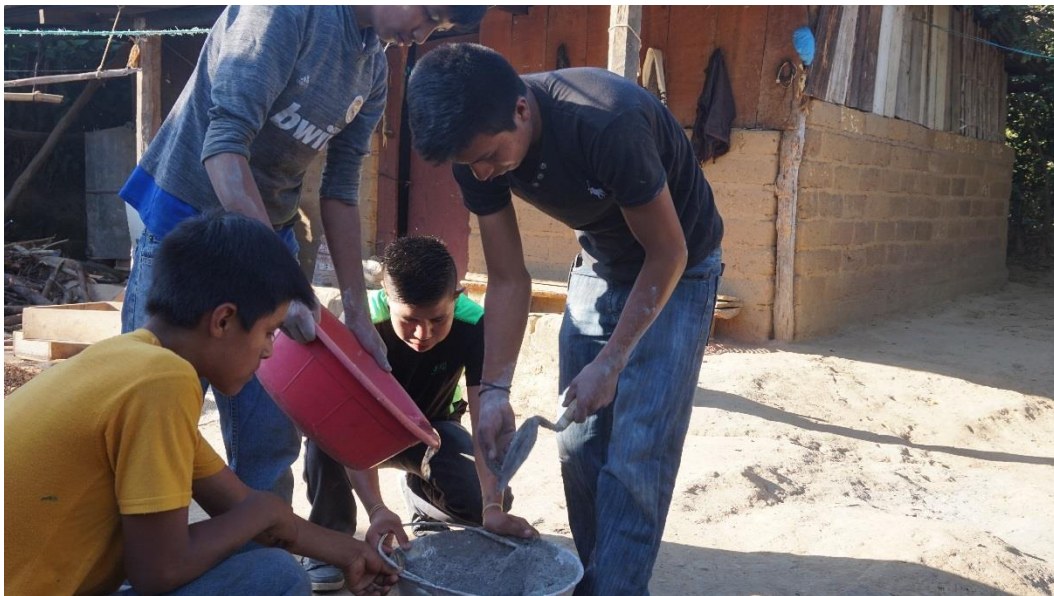
Grupo trabajando en la construcción de la estufa Foto tomada por Gamaliel Hernández
