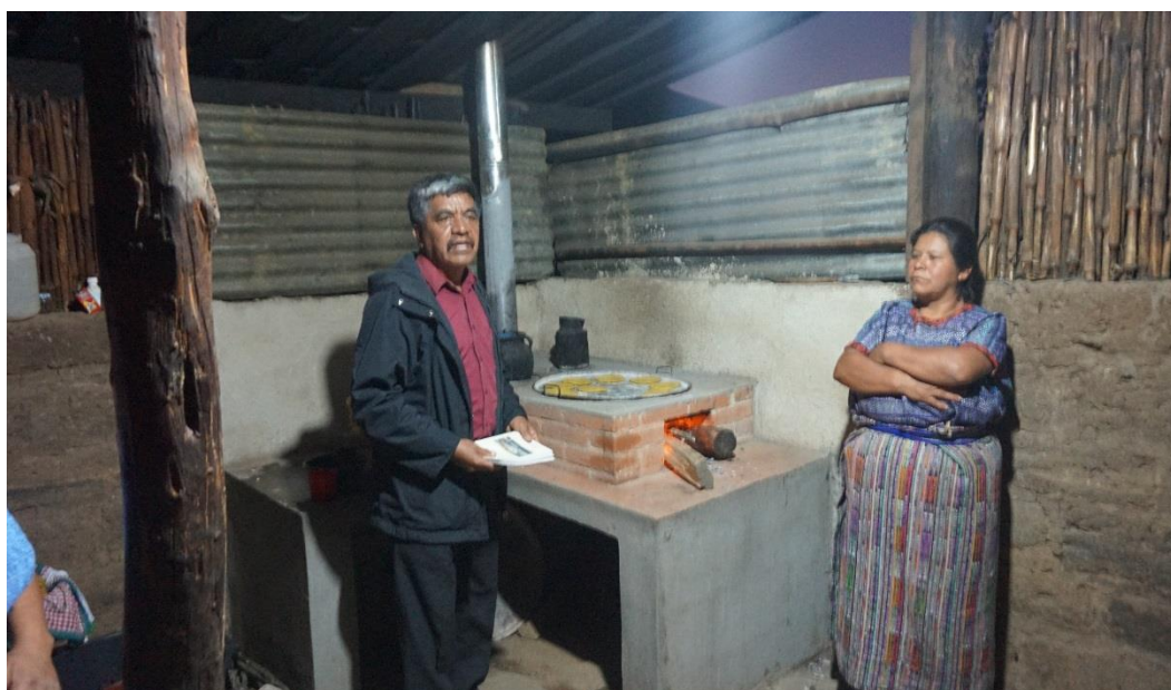
Estufa ahorradora construida en el lugar donde se encontraba el fogón abierto Foto tomada por Andrés Batz
