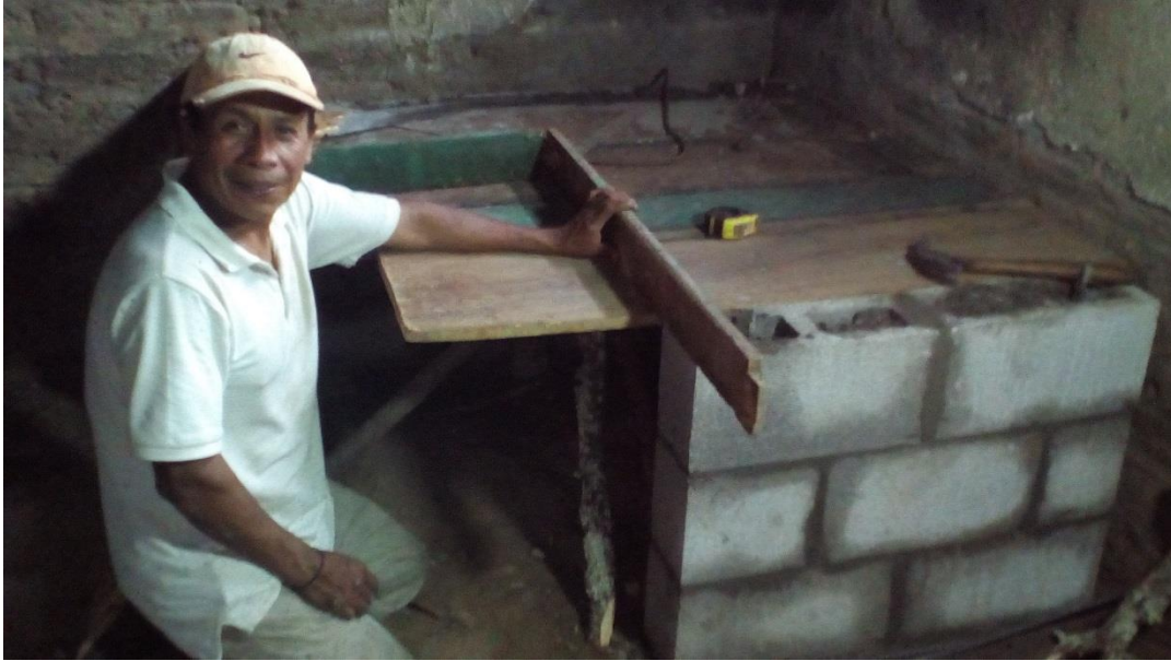
Albañil iniciando la construcción del pretil Foto tomada por Yovani Batz
