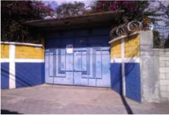
Fuente: Exterior de las instalaciones de la Asociación Rosas de Amor, ubicada en el callejón Shell 0-12 zona 2 San Lucas Sacatepéquez.
