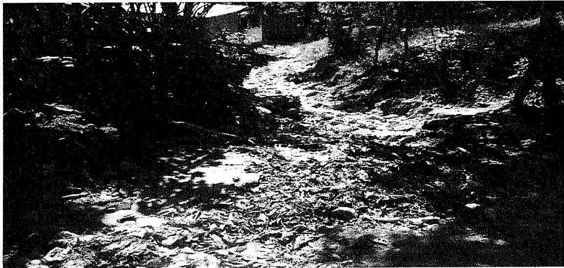
Caminos en mal estado, Aldea el Maguey
