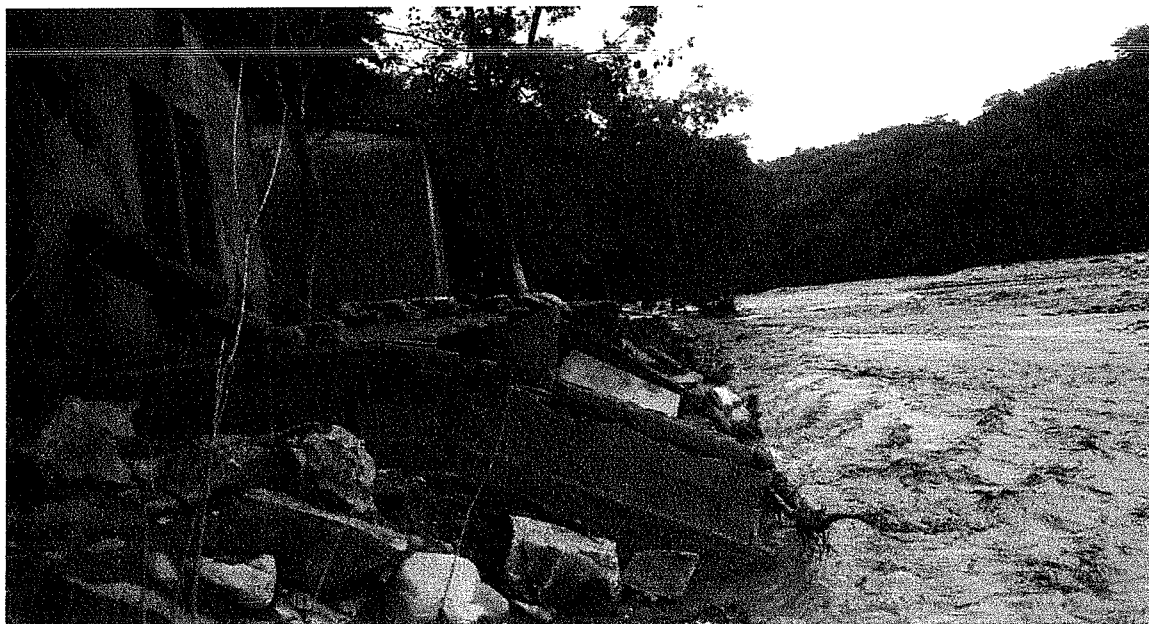
Inundación por crecida de río, Aldea Agua Blanca
